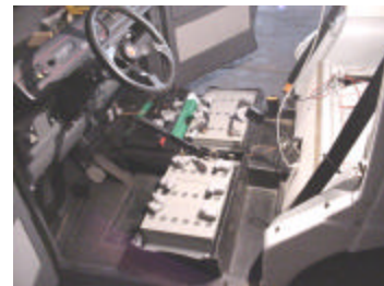
Baterías centrales de 48 V
